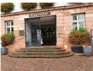
Treppe am Haupteingang
