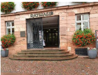
Treppe am Haupteingang
